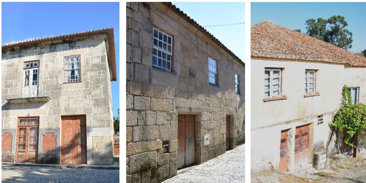
Figura 50: Exemplos de portas e janelas em madeira em Fonte Arcada
