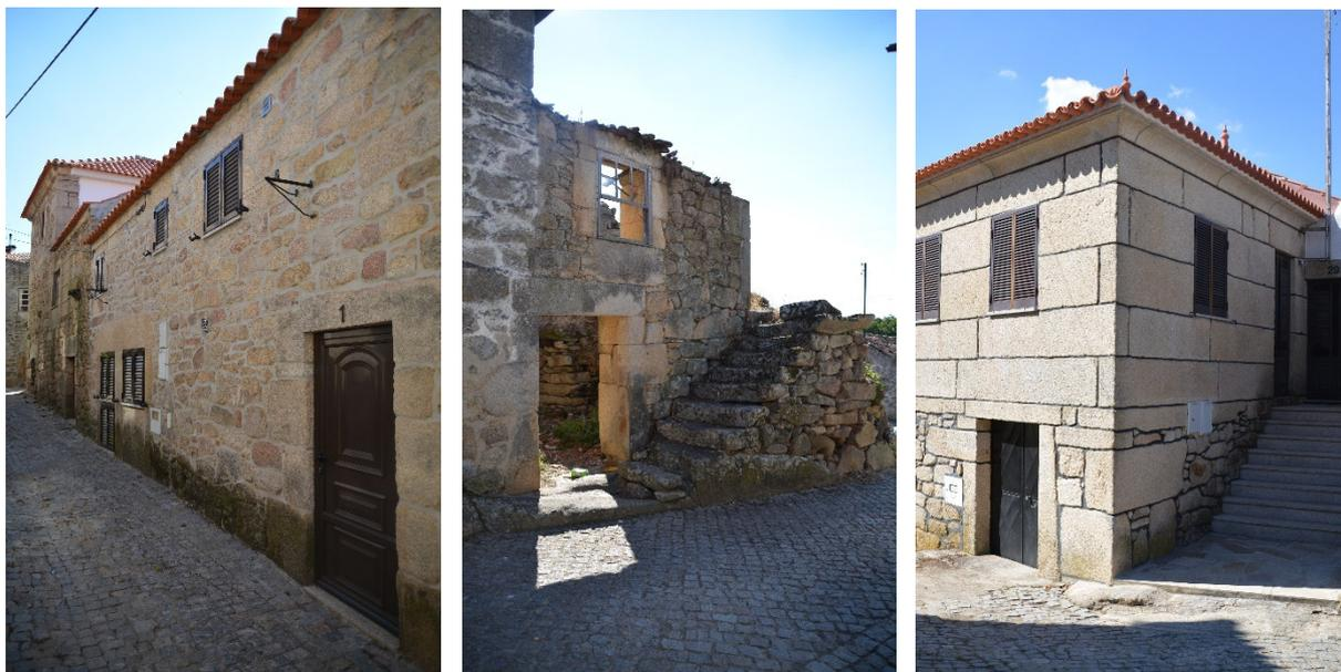
Figura 52: Exemplos de assentamento tradicional de alvenaria em pedra em Fonte Arcada
