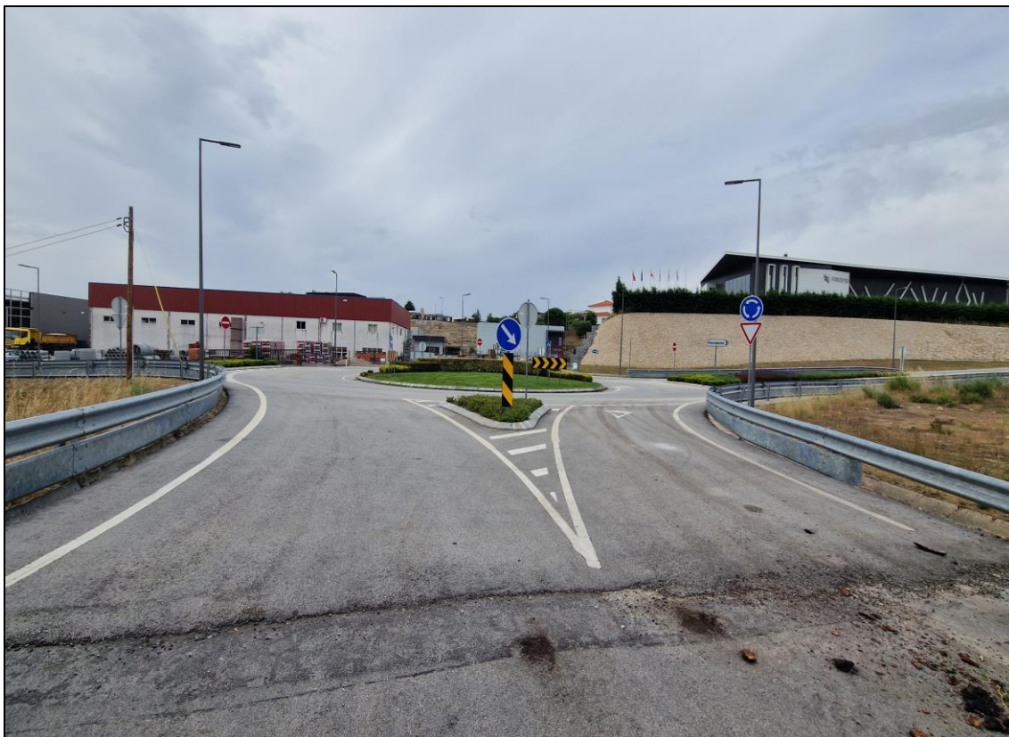
Fotografia n.º 18: Zona de acesso à Parcela – a partir da rotunda que serve a Zona Empresarial de Sernancelhe
