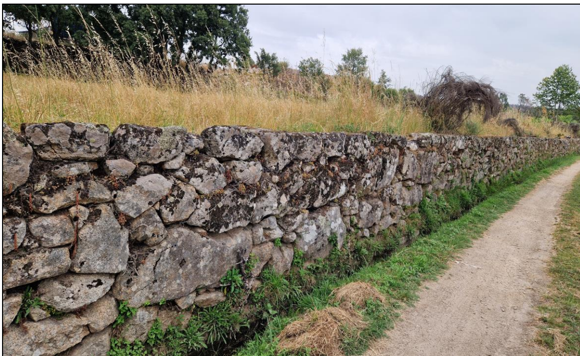
Fotografia n.º 13: Pormenor do muro de vedação
