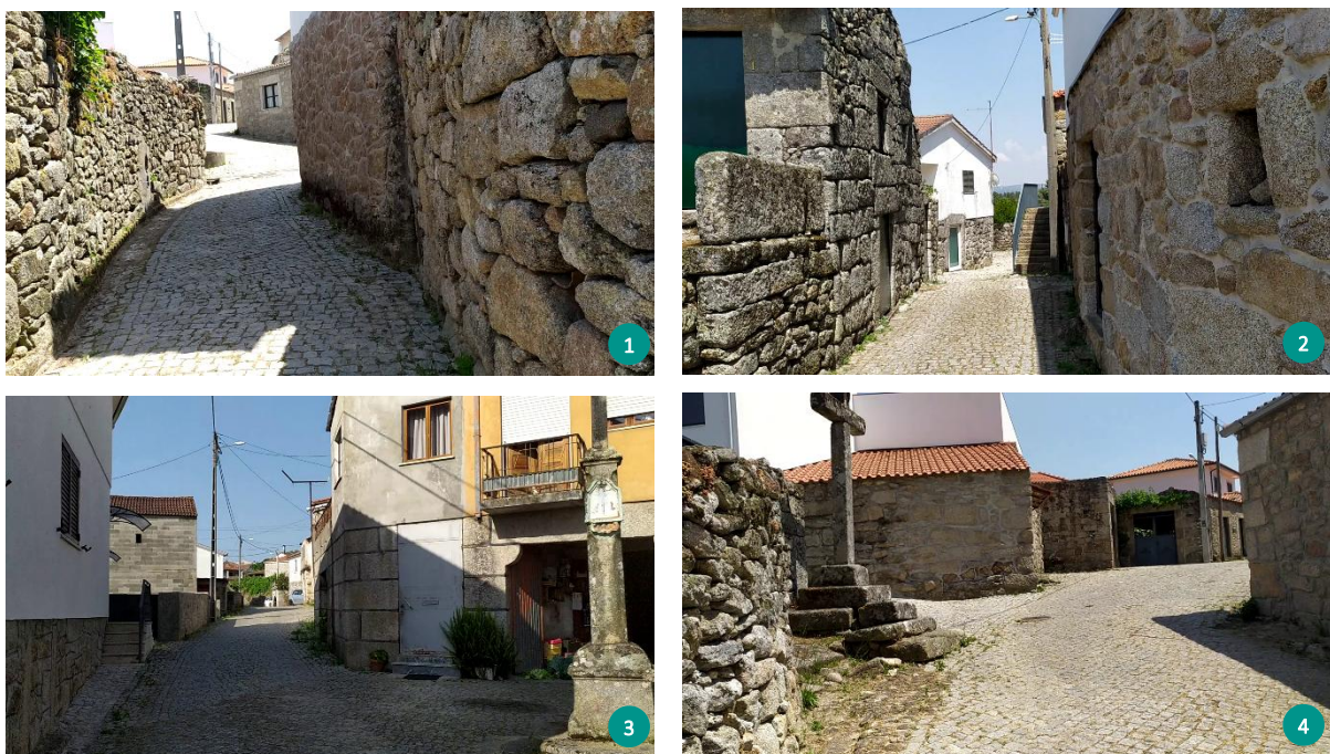
Figura 48 - Rede viária classificada como outros na ARU de Tabosa do Carregal - Este 1 – Rua de São Brás; 2 – Rua da Carga; 3 – Rua do Cruzeiro; 4 – Rua da Cruz de Pedra
