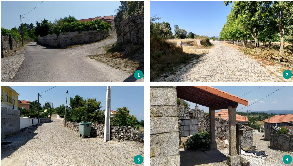
Figura 47 - Rede viária classificada como outros na ARU de Tabosa do Carregal - Oeste 1 e 2 – Rua da Saraiva; 3 – Rua do Quartelo; 4 – Rua dos Tormentos
