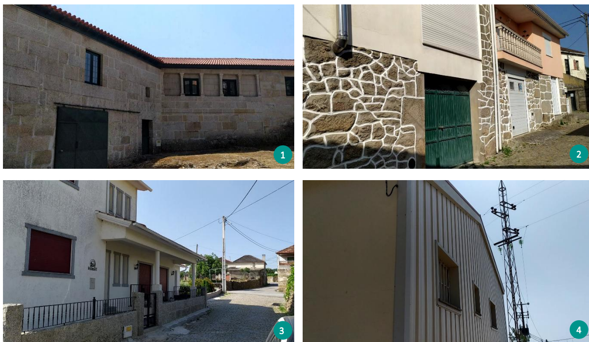
Figura 43 - Materiais usados na construção do edificado na ARU de Tabosa do Carregal 1 – Edifício em granito (Largo do Convento); 2 – Edifício em granito e betão (Rua da Mereceira); 3 – Edifício em betão (Rua do Cruzeiro); 2 – Edifício em betão e metal (Rua do Salão)
