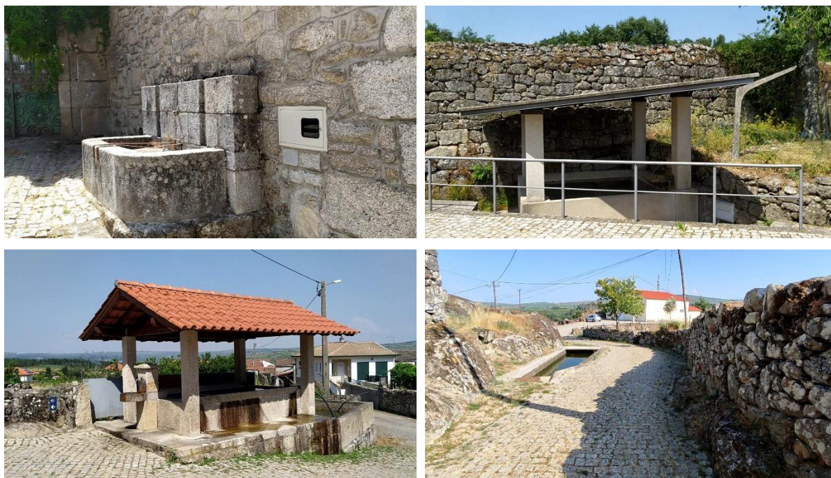
Figura 17 – Exemplos de fontes e tanques na ARU de Tabosa do Carregal
