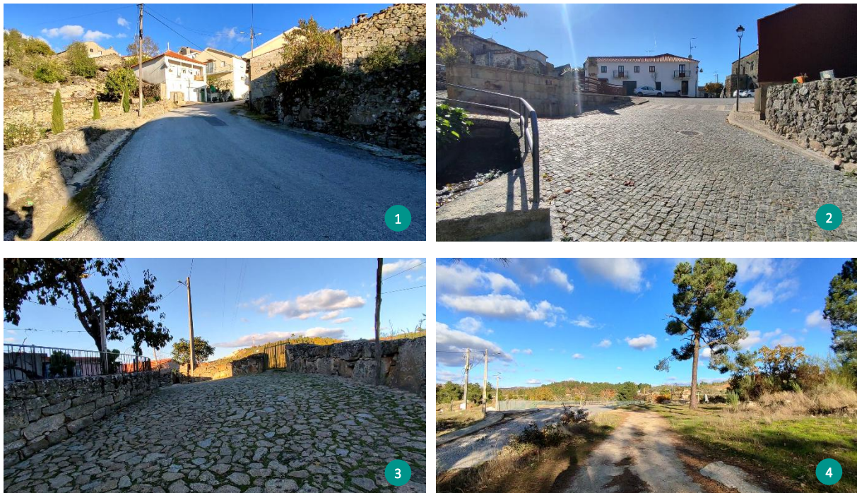
Figura 50 – Material de pavimentos na ARU de Fonte Arcada 1 – Betuminoso (Av. Franclim Quintais da Silva) da Saúde; 2 – Cubo de granito (Calçada da Fonte); 3 – Pedra Chão (Rua do Vale); 4 – Terra batida (Caminho junto ao polidesportivo)
