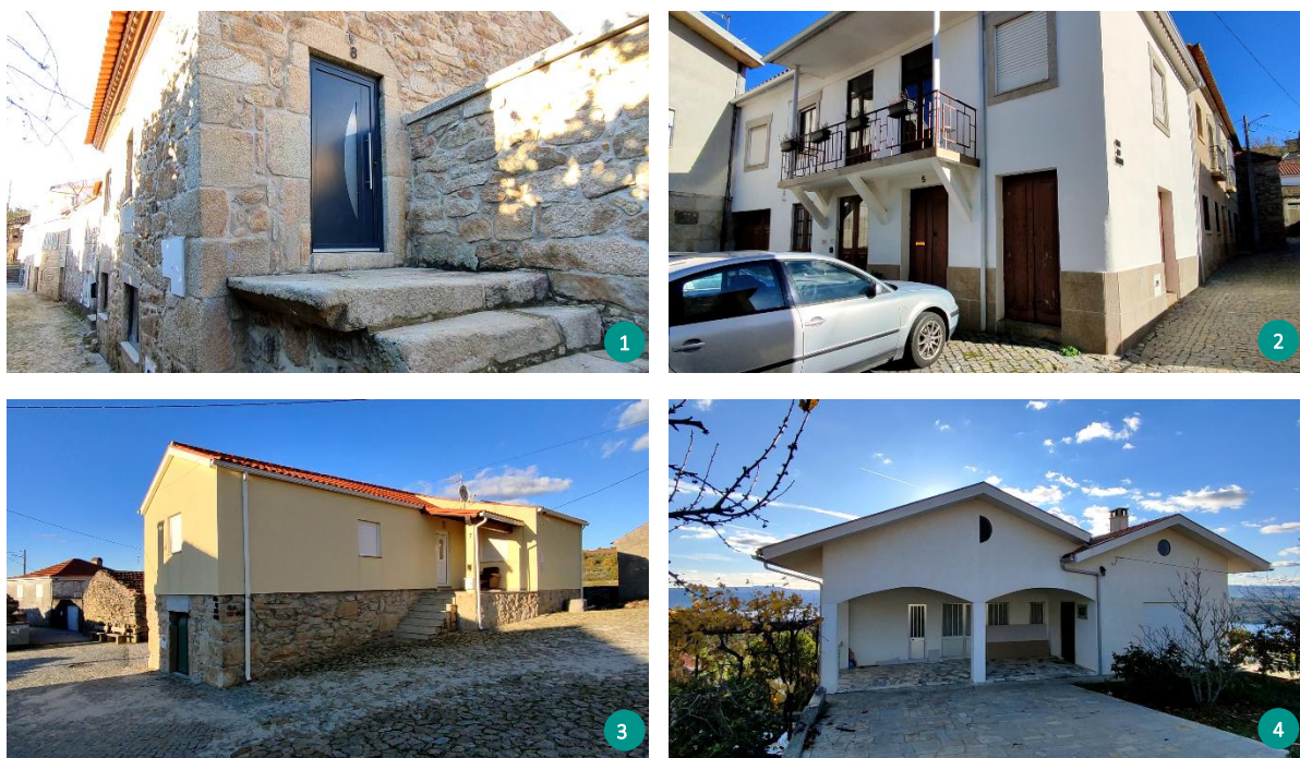
Figura 37 - Materiais usados na construção do edificado na ARU de Fonte Arcada
