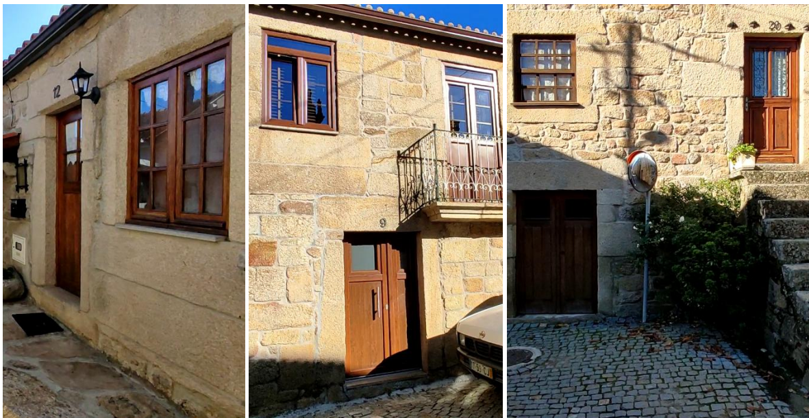
Figura 66 – Exemplos de portas e janelas em madeira em Fonte Arcada
