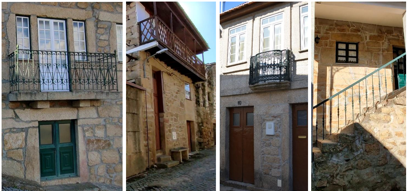
Figura 67 - Exemplos de elementos em ferro e em madeira em Fonte Arcada
