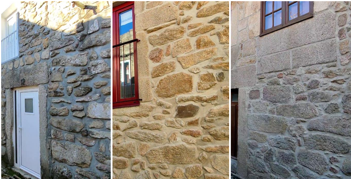
Figura 68 – Exemplos de paredes exteriores em alvenaria de pedra em Fonte Arcada
