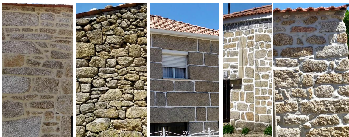
Figura 66 – Exemplos de paredes exteriores em alvenaria de pedra
