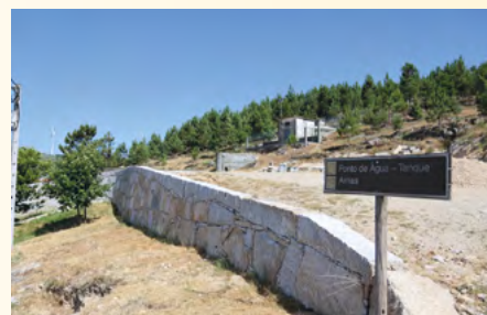
Construção de muro no acesso ao ponto de água
