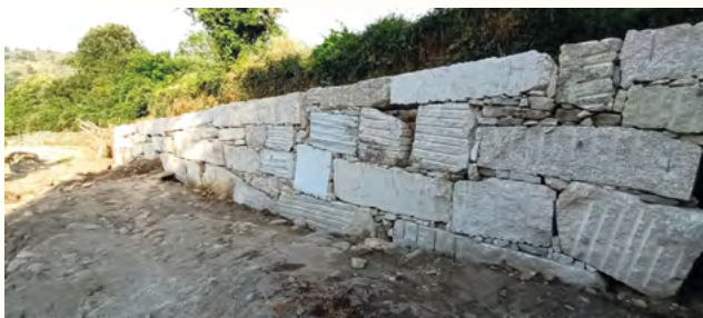
Construção de muro e alargamento de caminho
