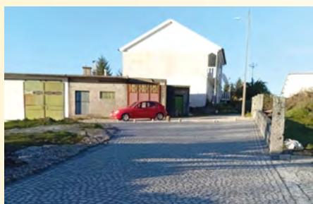
Calçetamento de várias ruas da freguesia
