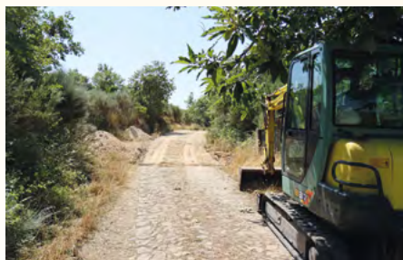
Calçamento do caminho agrícola dos Braceiros
