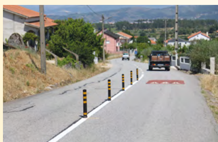
Colocação de lombas redutoras de velocidade
