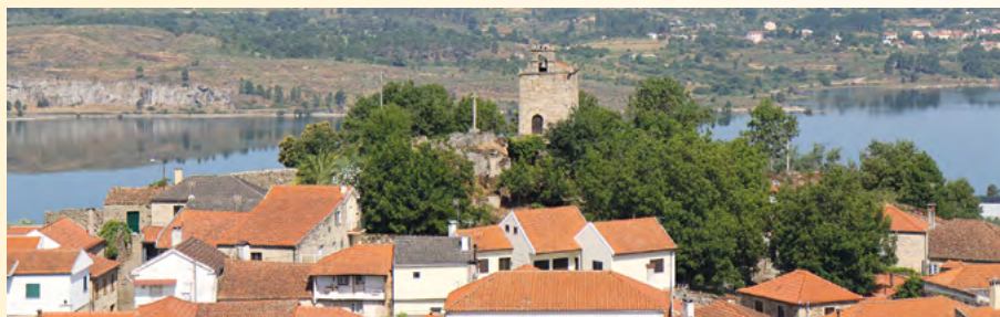
Intervenção na envolvente à Torre do Relógio
