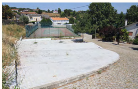
Construção do Parque Infantil
