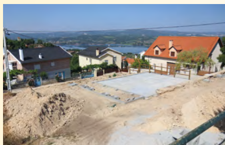
Construção do Parque de Lazer
