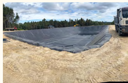
Construção de charca para proteção florestal
