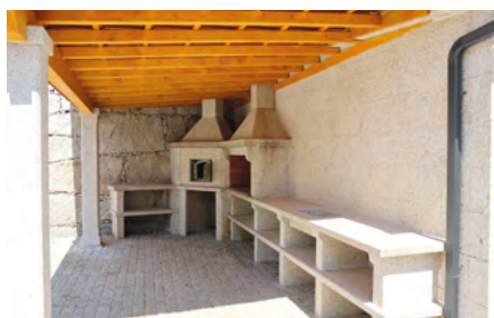
Construção de churrasqueira no espaço do Centro Lúdico
