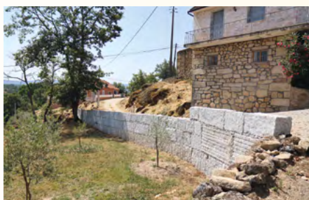
Construção de muro e alargamento do Caminho do Fieital
