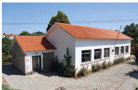
Substituição da Cobertura do Centro Lúdico
