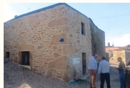
Conclusão da obra de reabilitação de habitação
