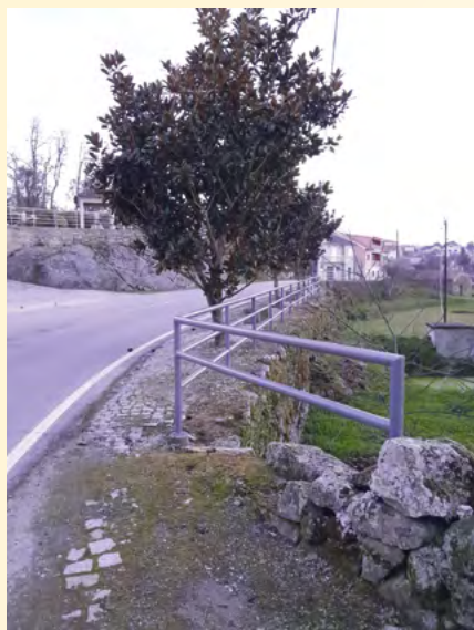
Colocação de gradeamento
