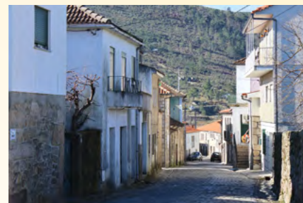
Eletrificação subterrânea na Rua Direita
