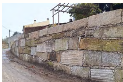
Alargamento da Rua do Cimo do Povo
