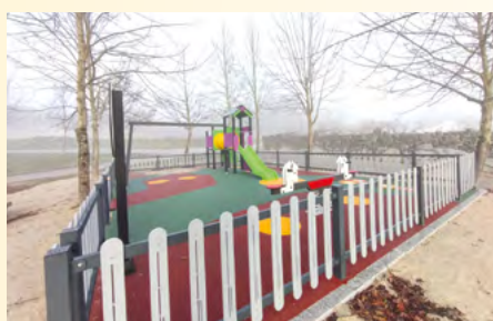
Tabosa do Carregal: Construção de parque infantil
