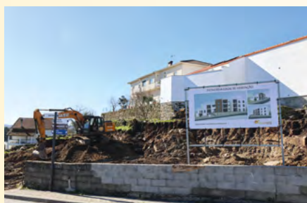
Intervenção no âmbito da Estratégia Local de Habitação
