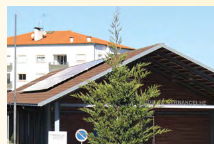
Colocação de painéis de produção de energia no edifício da USF TÁVORA
