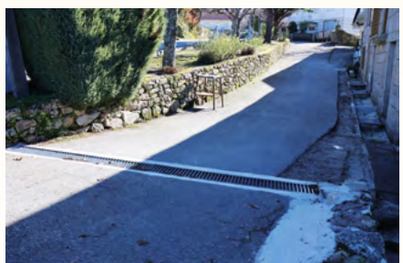
Colocação de grelhas para drenagem de águas na freguesia
