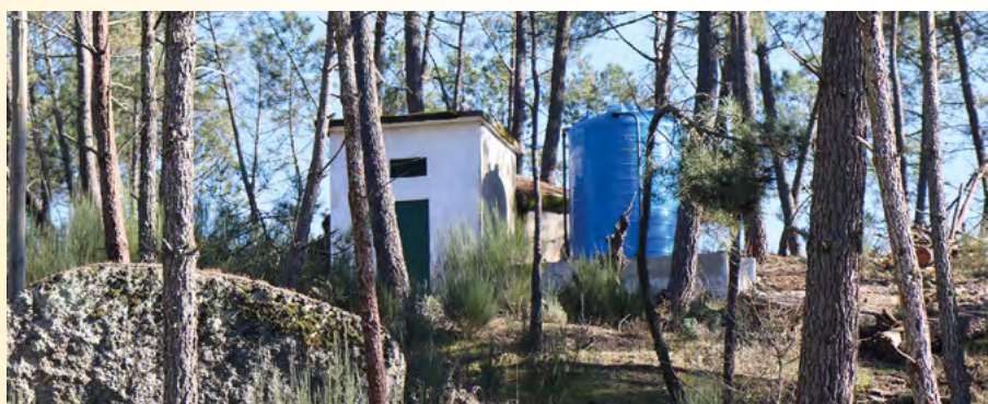
Colocação de reservatório provisório de água de abastecimento público
