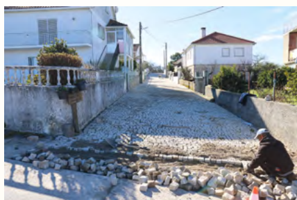
Calçetamento da Rua do Chão do Castanheiro
