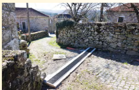
Colocação de grelhas para drenagem de águas na freguesia
