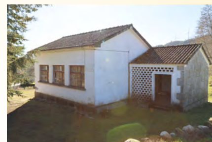
Requalificação do edifício da antiga escola primária da Quinta de Paulo Lopes - projeto em fase de elaboração
