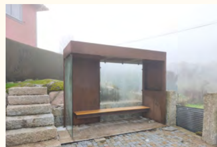
Aldeia de Santo Estevão: construção de paragem de autocarro
