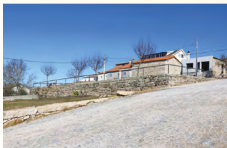
Calçetamento do acesso ao futuro parque infantil
