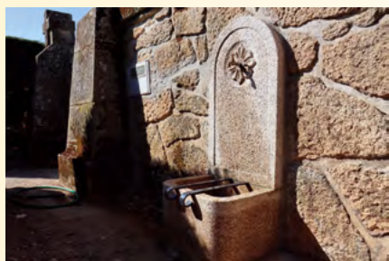
Construção de fontanário no Cemitério
