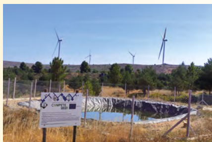
Construção e vedação da Charca da Serra do Pereiro
