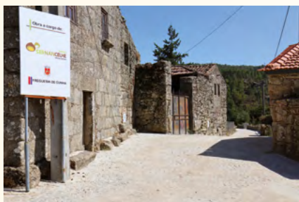
Calçetamento na Rua do Sino
