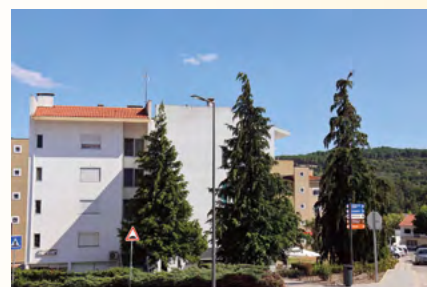
Substituição de cobertura do edifício Santa Cruz
