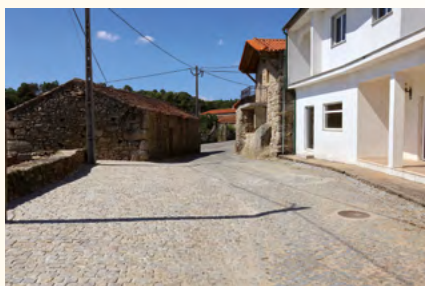
Calçetamento na Rua do Valado
