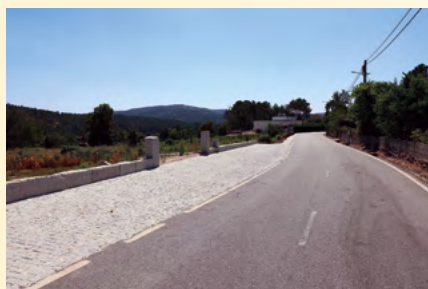
Calçetamento junto à Estrada Municipal
