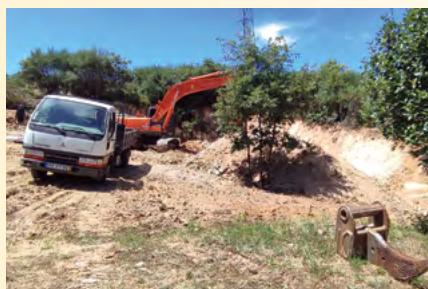
Limpeza Nascente de abastecimento público de água - Tabosa do Carregal
