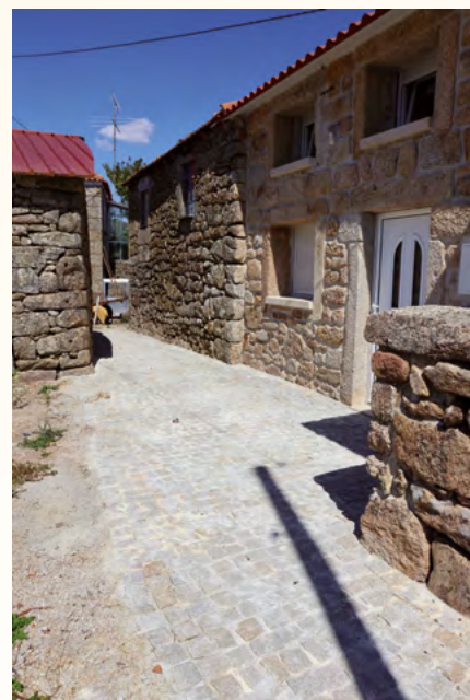
Calçetamento na Rua do Ribeiro
