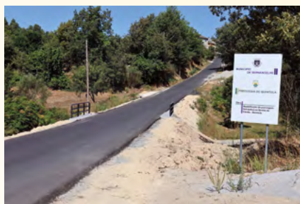
Reabilitação da passagem hidráulica na Quinta do Cando
