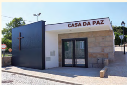
Construção da Casa Mortuária
