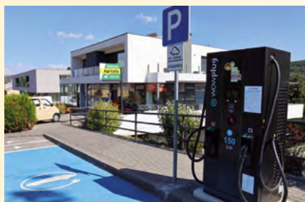
Colocação de carregador de 150 KW na vila de Sernancelhe
