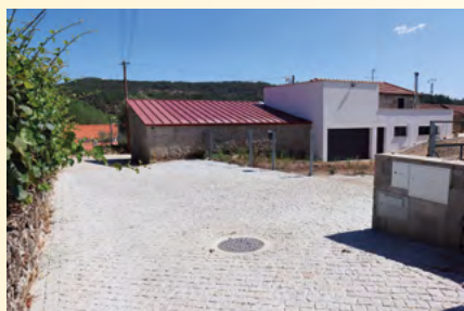
Calçetamento na Rua da Portela
