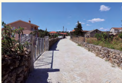
Calçetamento na Rua do Sino
