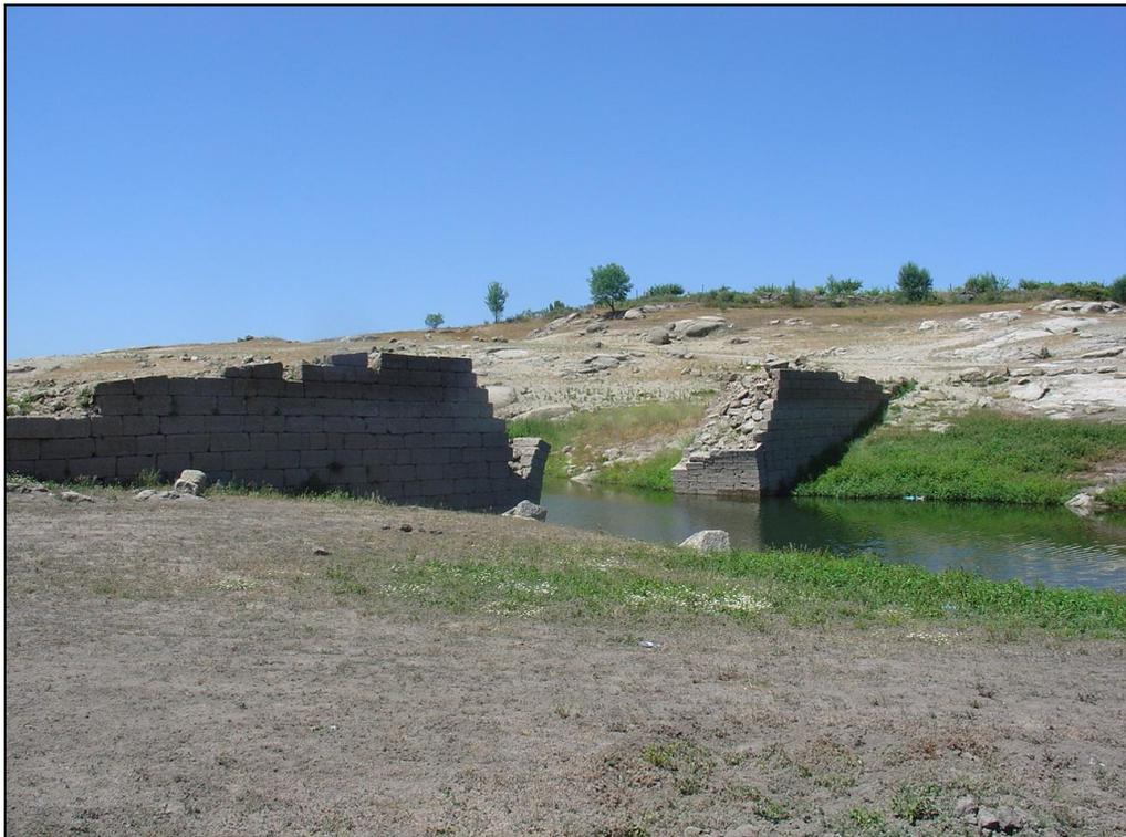
**Imagem 120. Aspecto actual da ponte de Freixinho, pode-se observar que o arco da ponte apenas apresenta os arranques.**
