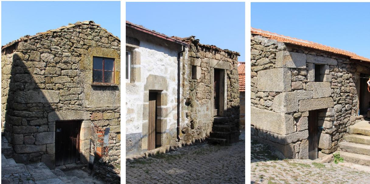
*Figura 47 - Exemplos de paredes exteriores em alvenaria de pedra em Macieira*
