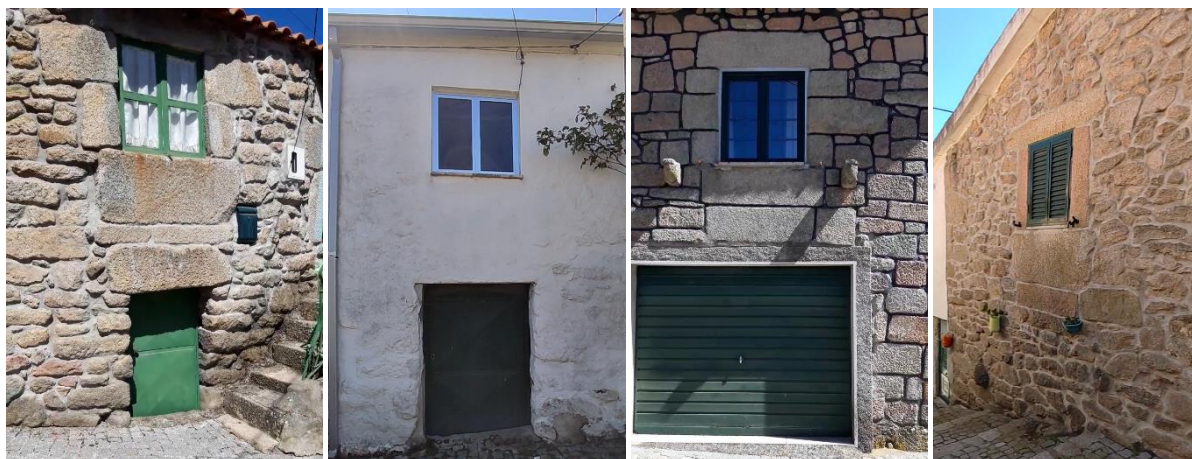
Figura 58 – Exemplos de paredes exteriores em alvenaria de pedra
