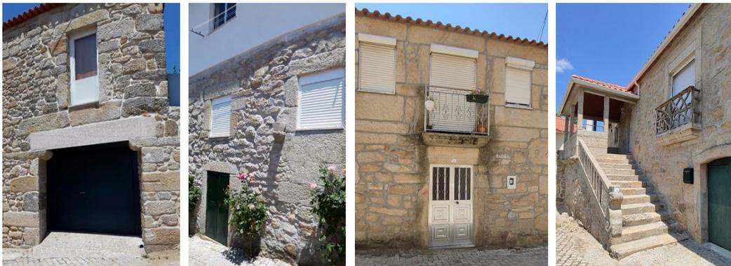
Figura 64 – Exemplos de paredes exteriores em alvenaria de pedra
