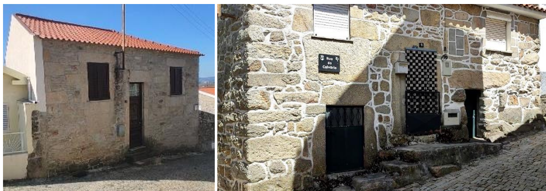
Figura 47 – Edifícios com estrutura em alvenaria de granito
