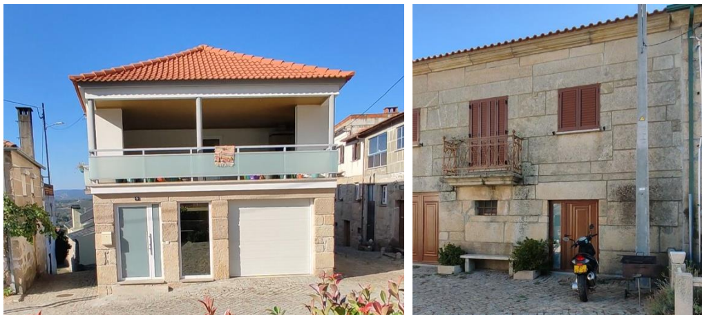
Figura 37 – Edifícios em excelente estado de conservação
