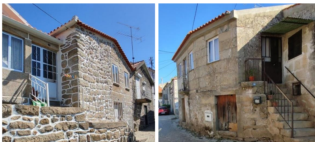
Figura 38 - Edifícios em bom estado de conservação
