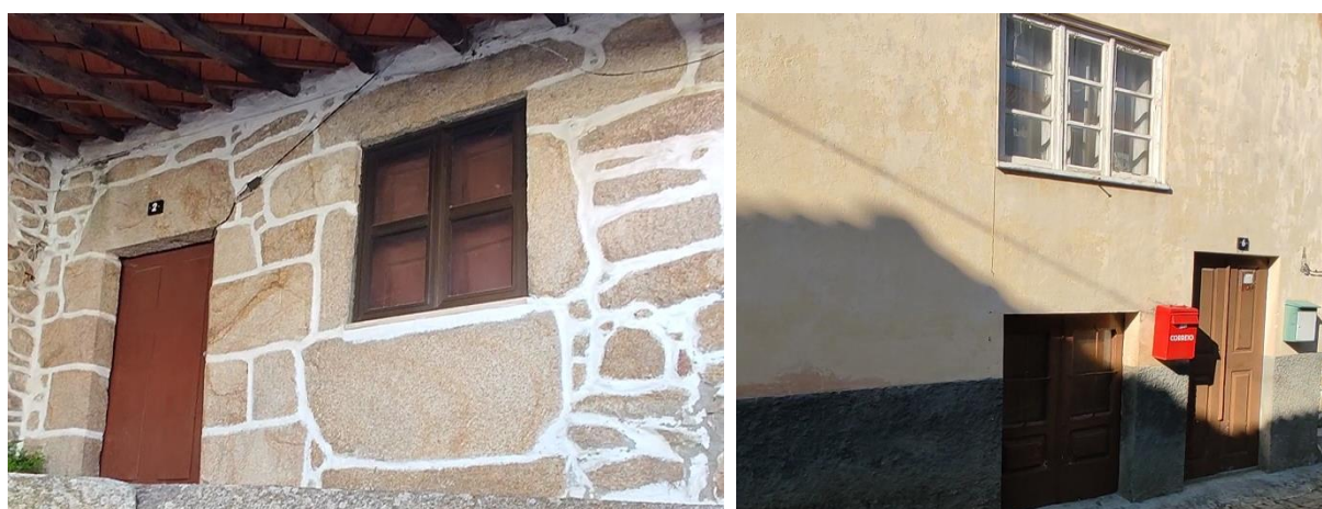
Figura 76 – Exemplos de portas e janelas em madeira
