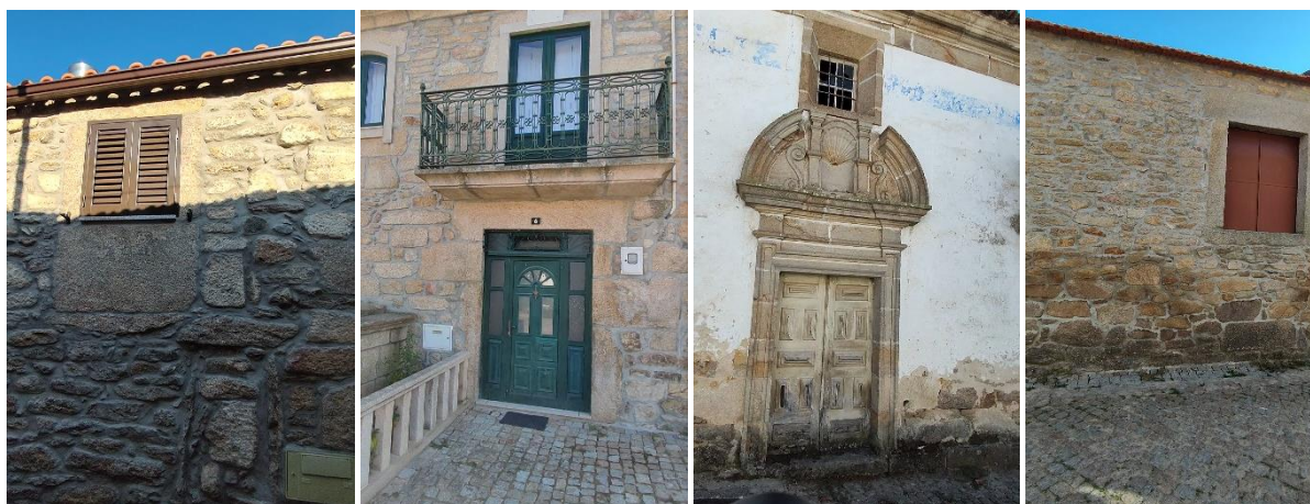
Figura 77 – Exemplos de paredes exteriores em alvenaria de pedra
