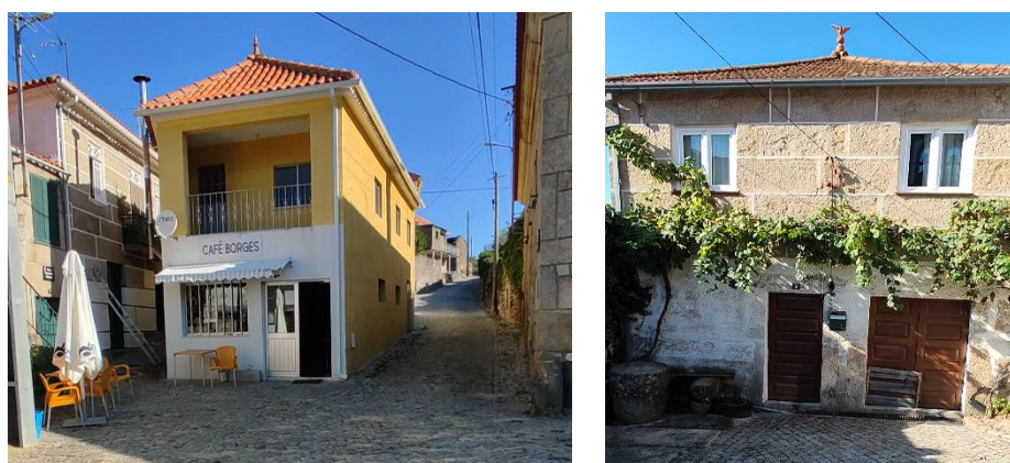
Figura 28 – Habitação Parcial – À esquerda: edifício 42, e à direita: edifício 56.
