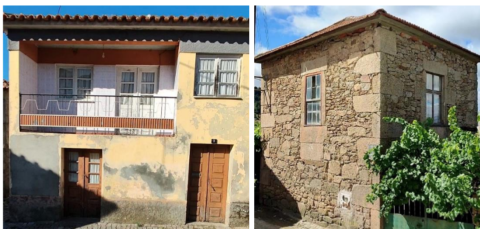
Figura 39 – Edifícios em médio estado de conservação
