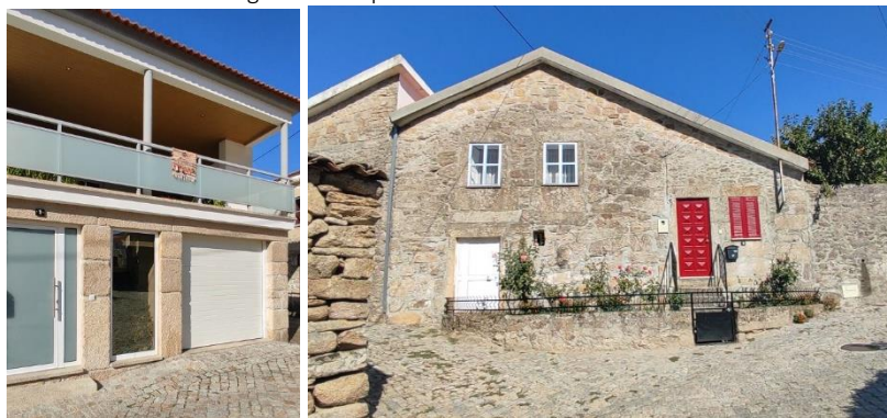
Figura 49 Edifícios com estrutura em alvenaria de granito e betão armado
